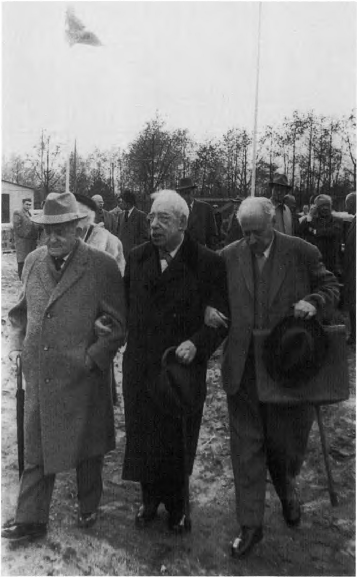
Richtfest des Neubaus des Israelitischen Krankenhauses am 28. Oktober 1959, von links Harry Goldstein, Dr. Fritz M. Warburg, Felix Epstein.
